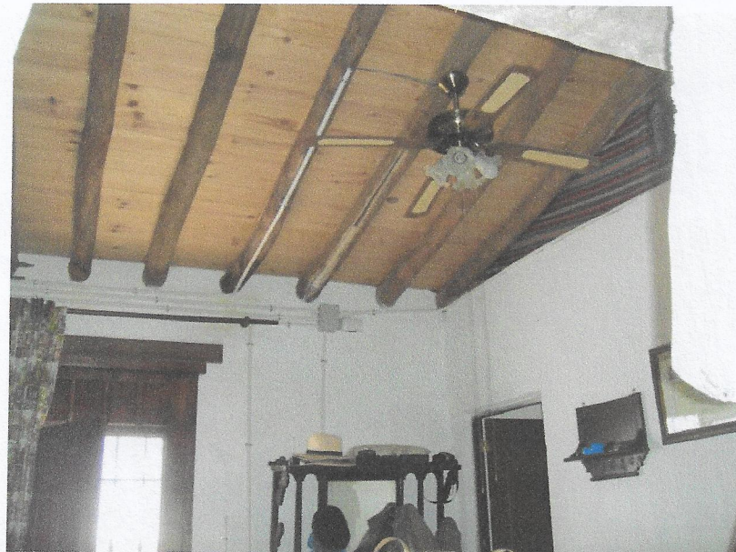
Fotografía 12. Vista parcial del techo inclinado del Zaguán.
