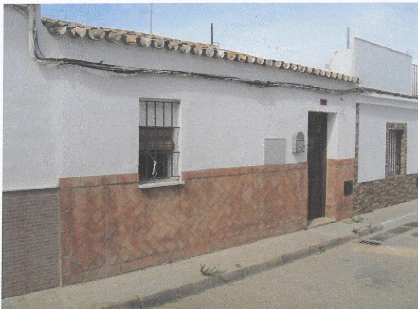
Fotografía 1. Vista de la Fachada Principal a la Calle Nazaret.
