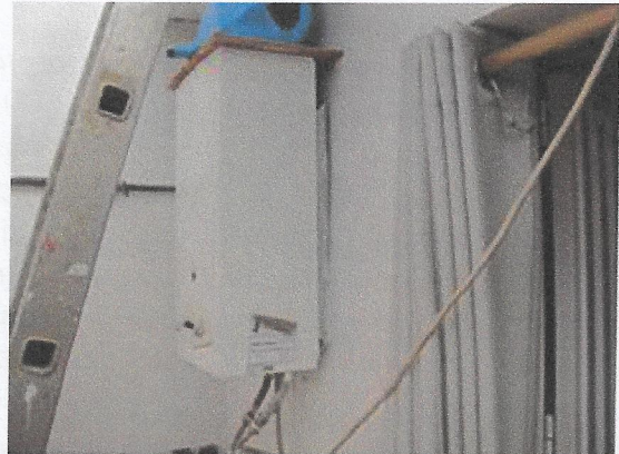
Armario en Fachada y Termo a GLP
