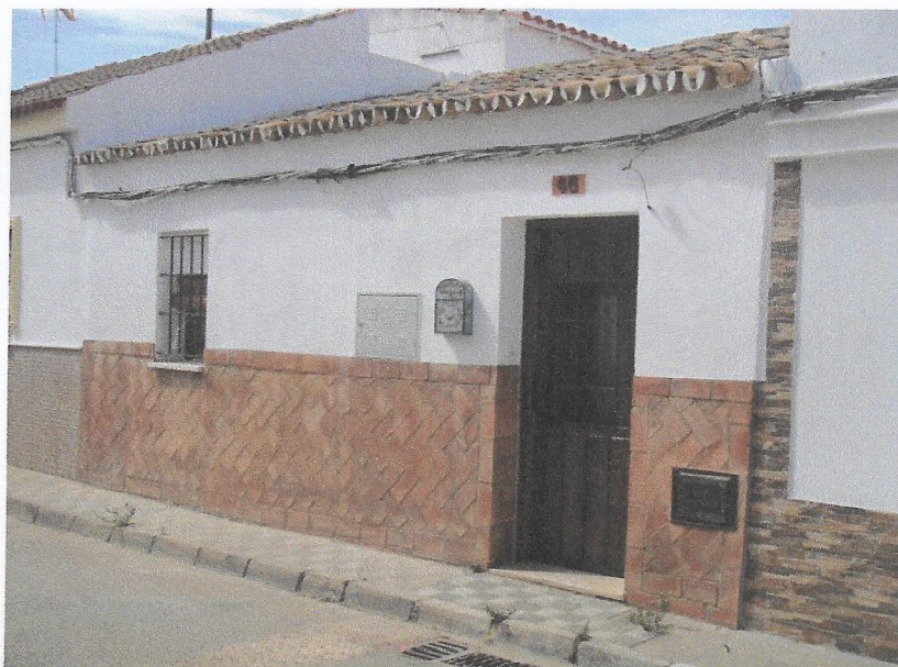
Fotografía 2. Vista de la Fachada Principal a la Calle Nazaret.
